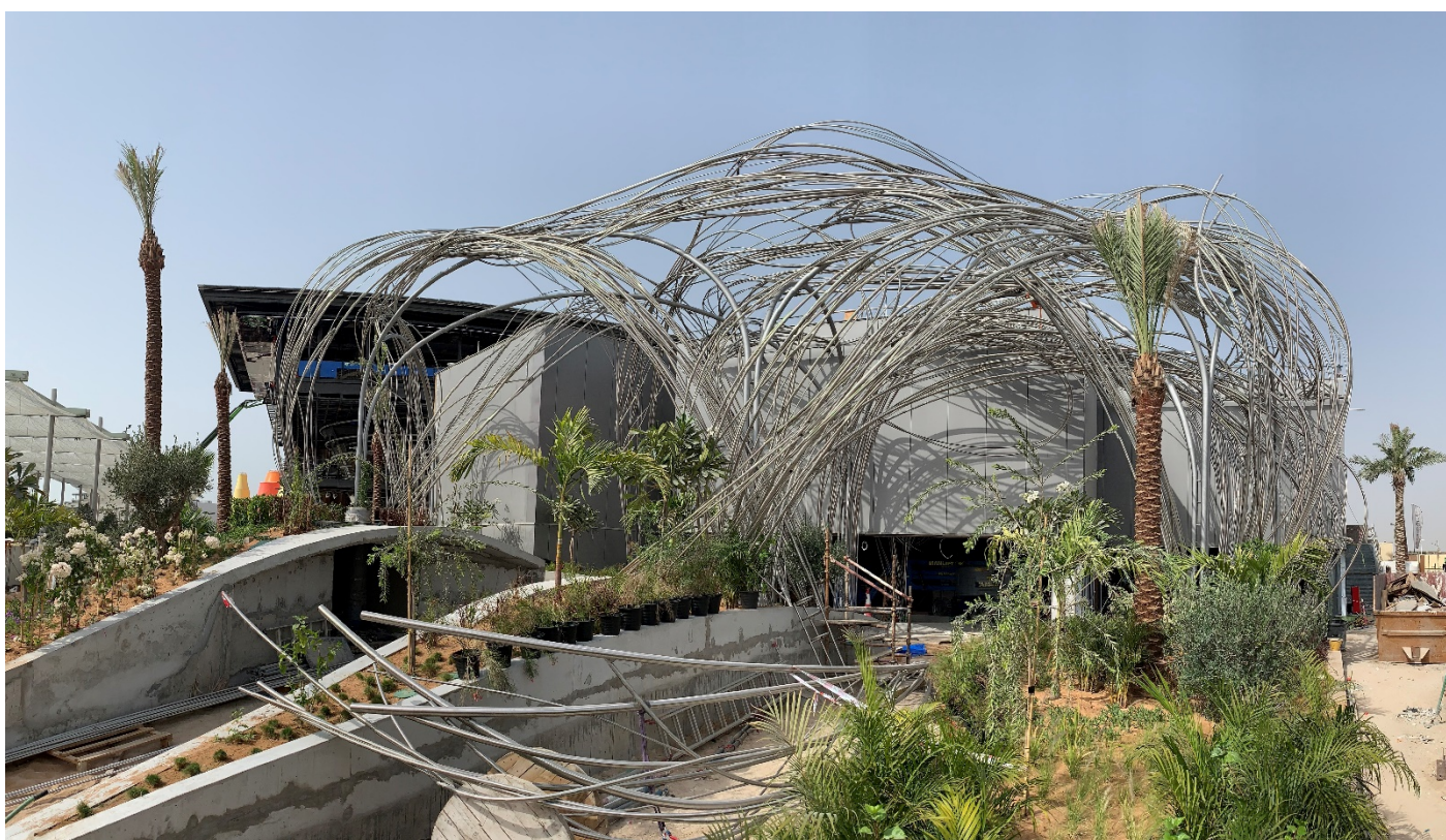
Stav pavilonu k 21.03.2021
